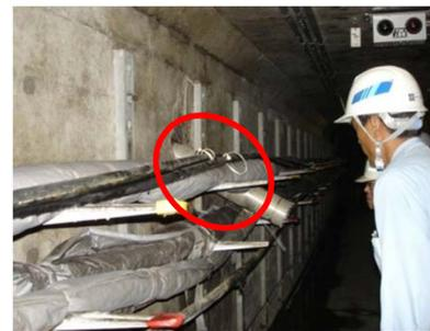
薬液注入ロッド貫通場所(ロッド径53mm) 漏水量1~2ℓ/min
